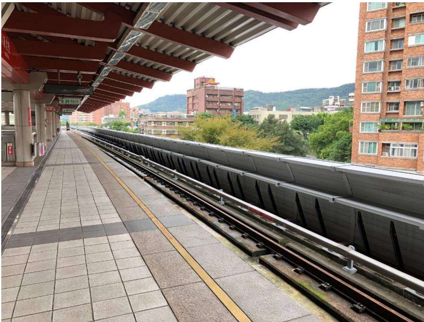
新北投捷運吸隔音牆
