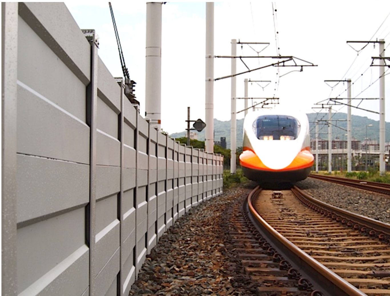
台灣高鐵左營站吸隔音牆
