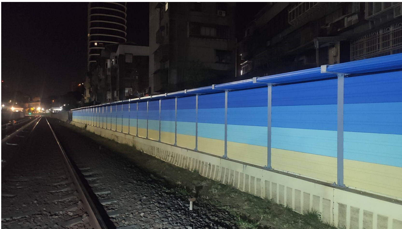
台北捷運淡水線吸隔音牆
